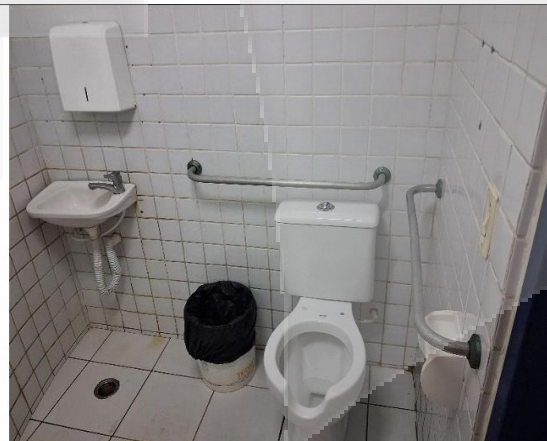
FOTO 11- BANHEIROS COM BARRAS
